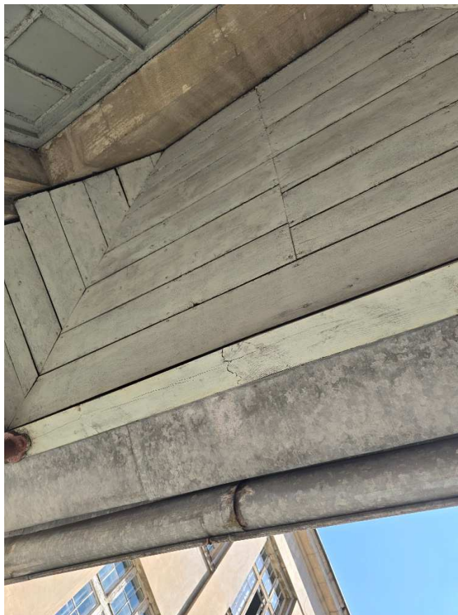
Fot. nr 6 – widok podsufitki z desek przy schodach D
