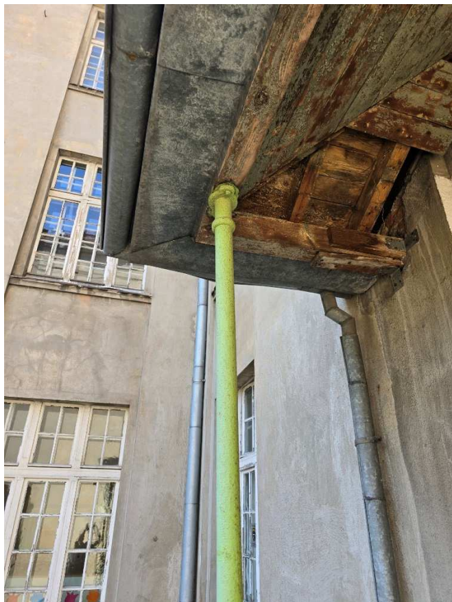
Fot. nr 5 – widok podsufitki przy schodach C
